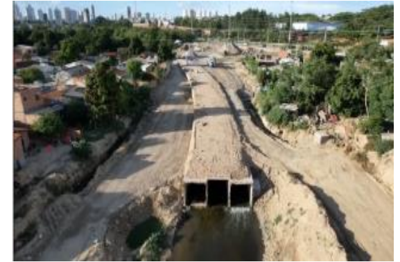
Continuidade obra Av. Parque Barbado
