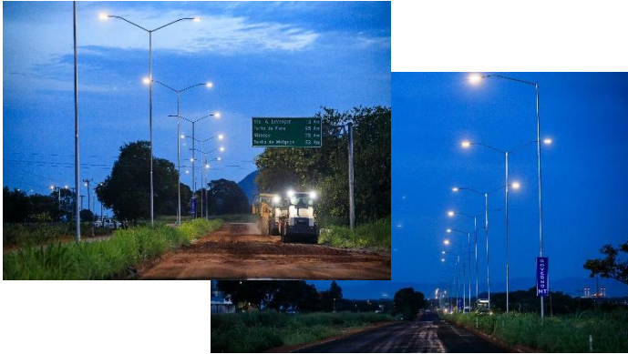
Iluminação MT 040 (trecho 17km até entrada de Santo Antonio do Leverger)
