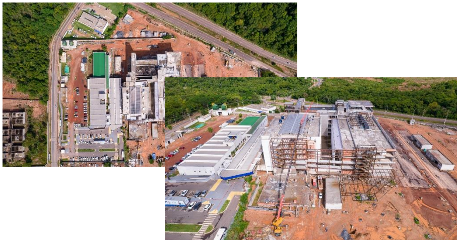
Adequação Viária Entorno Novo Hospital Central
