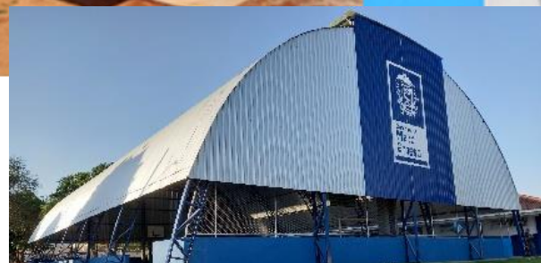
Construção de quadra poliesportiva
