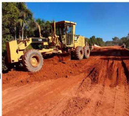
Manutenção de Rodovia Não Pavimentada (MT-242)
