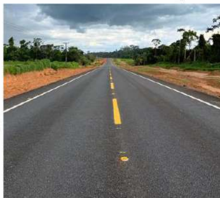
Pavimentação Rodovia MT-322 (I.C. 017/2013)
