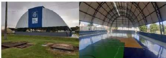
Construção de quadra poliesportiva - Escola Estadual Marcio Schabatt – Lucas do Rio Verde.
