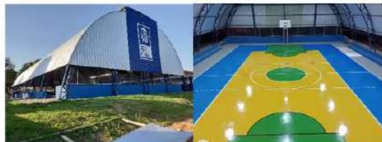
Construção de quadra poliesportiva - Escola Estadual Antônio Guimarães Balbino – Rondonópolis.
