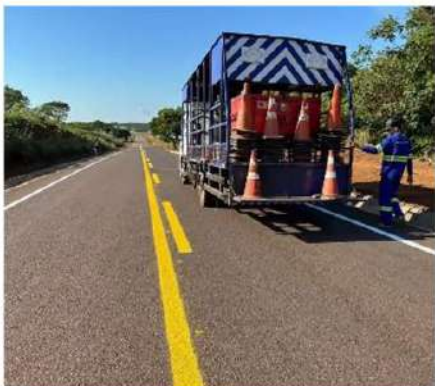
Pavimentação Rodovia MT-020 (I.C. 045/2020)
