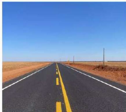
Pavimentação Rodovia MT-485 (I.C. 046/2020)
