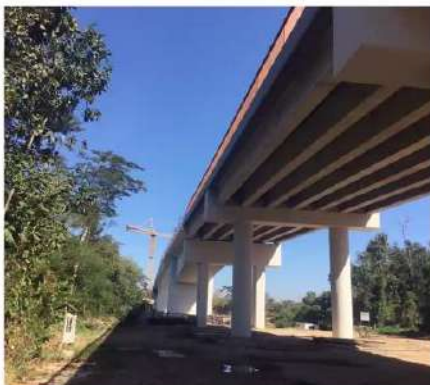
Ponte sobre o Rio Cuiabá - Atalaia (PT02412)
