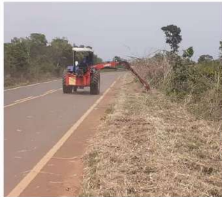
Manutenção de Rodovia Pavimentada (MT-235)
