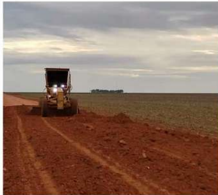
Manutenção de Rodovia Não Pavimentada (MT-488)
