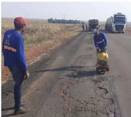
Manutenção de Rodovia Pavimentada (MT-338)
