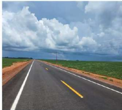
Pavimentação Rodovia MT-429 (L.C. 017/2022)
