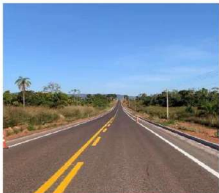
Pavimentação Rodovia MT-343 (I.C. 042/2014)
