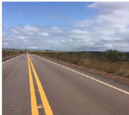
Pavimentação Rodovia MT-140 (I.C. 001/2008)
