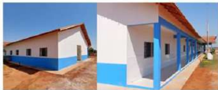
Ampliação de 04 salas de aula - Escola Estadual Ângelo Milhorança - Nova Maringá.
