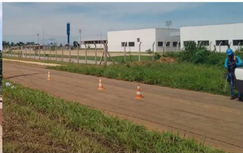
Visão da rua em frente a ZPE
